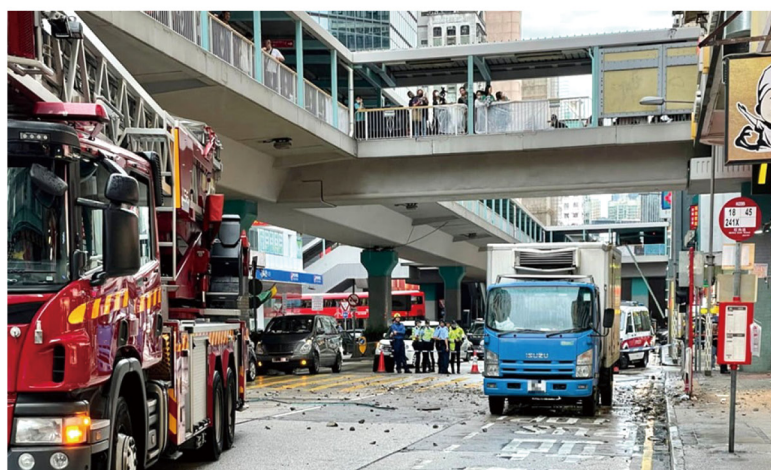
圖五：樓宇外牆石屎剝落事故
