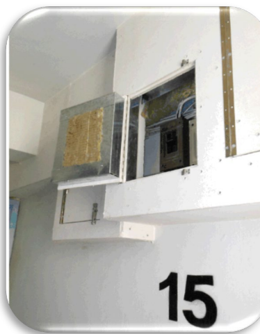
以耐火物料圍封 非緊急設施
