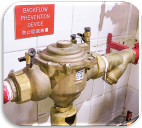
折衷式喉轆系統 防止回流裝置
