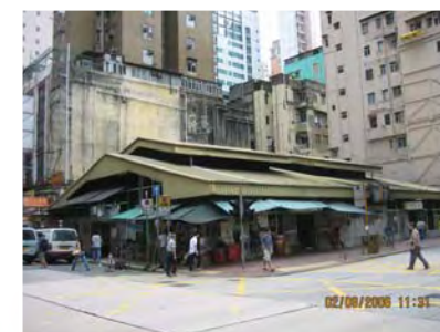
現況 Existing Condition
