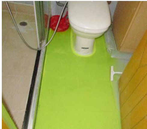
圖三及圖四：聯辦處聘用的顧問公司在涉事單位使用色水進行地台蓄水測試以及使用微波斷層掃描查找滲水源頭
